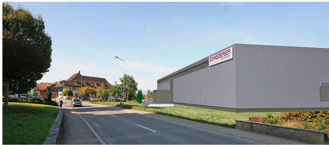
Der Neubau an der St. Urbanstrasse wird unterirdisch mit dem bestehenden Firmengebäude auf der anderen Seite verbunden sein. Eine Grünzone wird die Sicht auf den schützenswerten Bären im Hintergrund sichern. zvg
